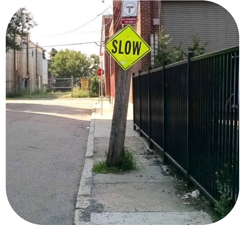
Kondisons ki dja Izisti, Glover's Corner
