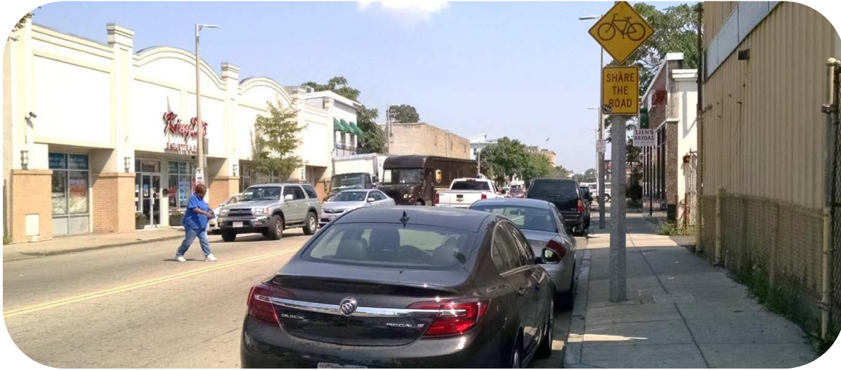
Kondisons ki dja Izisti, Glover's Corner
