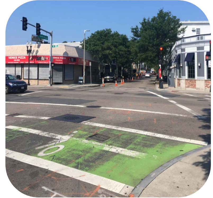
Kondisons ki dja Izisti, Glover's Corner
