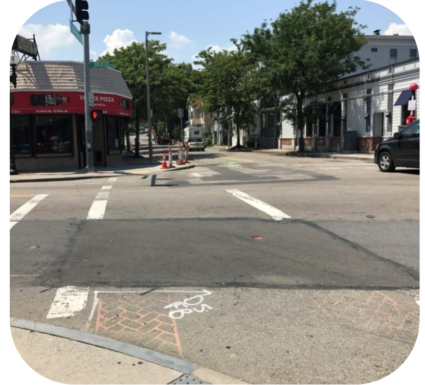
Kondisons ki dja Izisti, Glover's Corner
