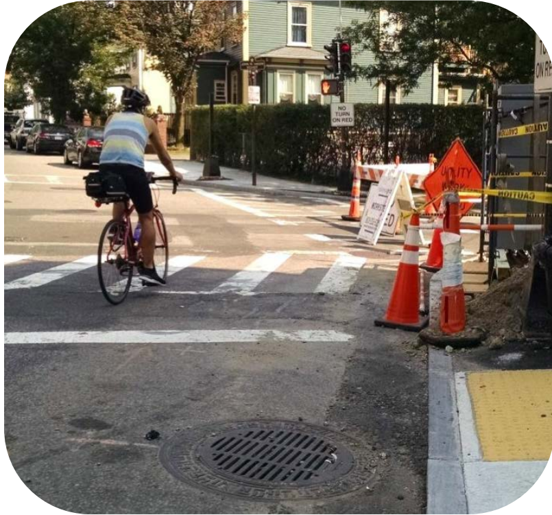
Kondisons ki dja Izisti, Glover's Corner
