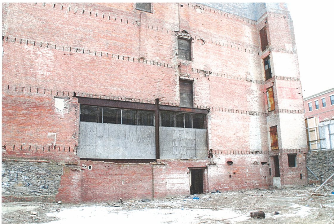
Photo F0.8 - Basement
