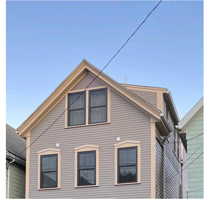
El tratamiento de las ampliaciones depende del contexto. Las ampliaciones de menor tamaño se pueden tratar de manera similar al edificio existente, como la buhardilla de arriba.
