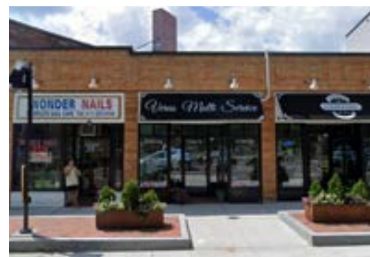
Edificios más grandes de uso combinado y algunos usos cívicos ubicados a lo largo de Washington Street y Belgrade Avenue.
