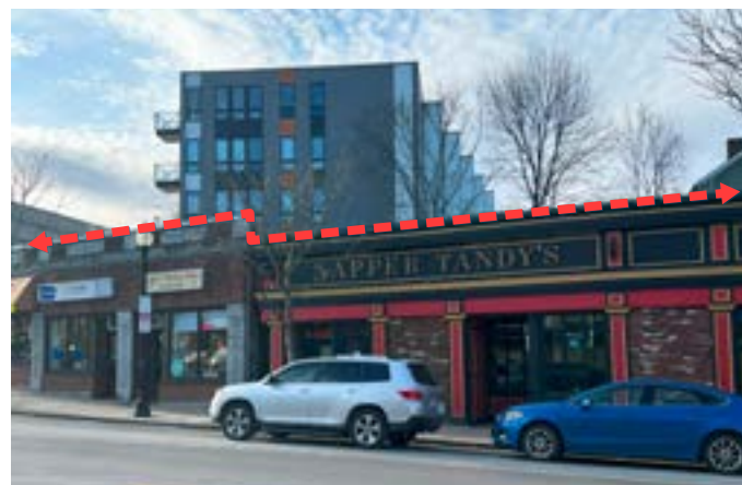
Fachadas de tiendas en la calle Washington con condición de medianera en los límites laterales de los lotes
