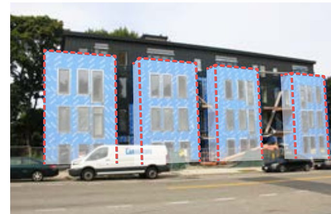
Proyecto del Artículo 80 en construcción en 59-63 Belgrade Avenue, que incluye divisiones verticales de 3 pisos para reducir la escala
