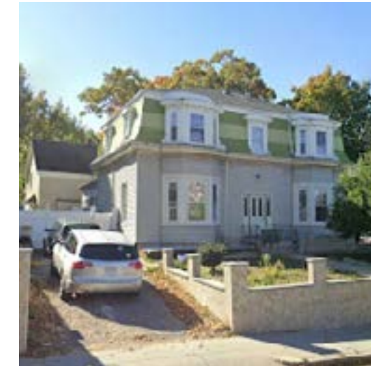
Ejemplo de un techo estilo mansarda con ventanas mirador
