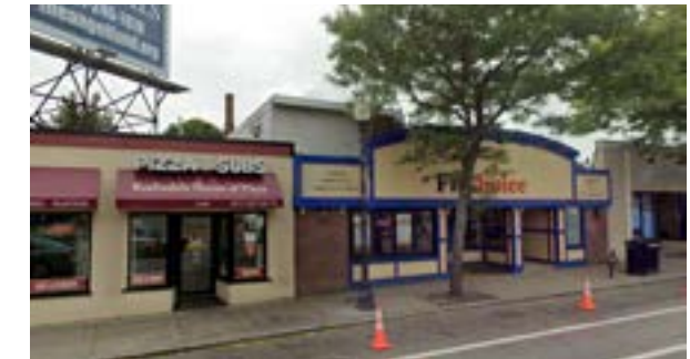
Fachadas comerciales de una y dos plantas en el lado sureste de Washington Street, con algunos usos automotrices y edificios vacíos.
