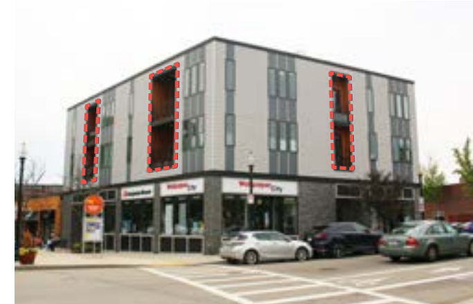
Balcones retranqueados en los pisos superiores para las unidades residenciales sobre Wallpaper City
