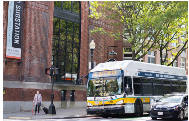
Subestación de Roslindale
