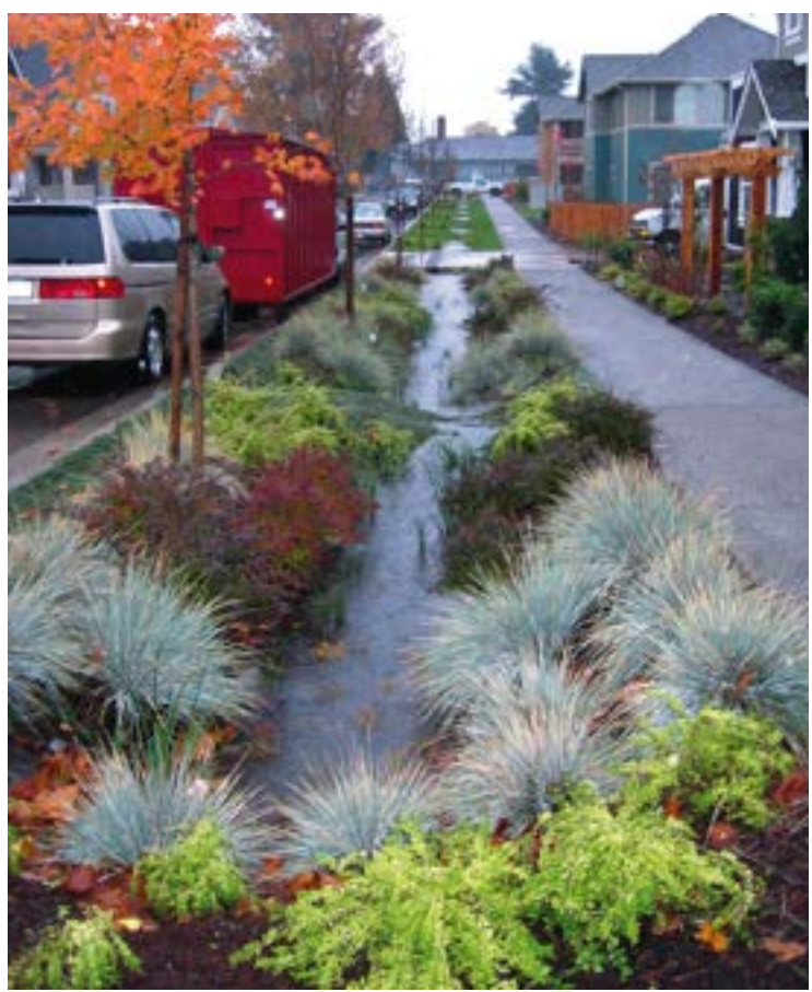
Vegetated bioswale Source: EPA Watershed Academy Jardinería con sistema de biofiltración Fuente: EPA Watershed Academy
