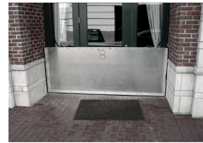
Dry-Floodproofing Protección seca contra inundaciones
