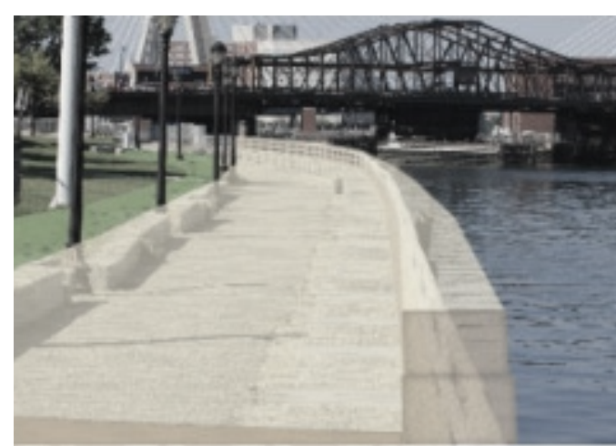
Harborwalk Barrier / Seawall Barrera / pared marítima en la bahía
