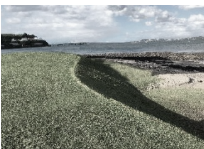
Vegetated Berm Arcén con vegetación
