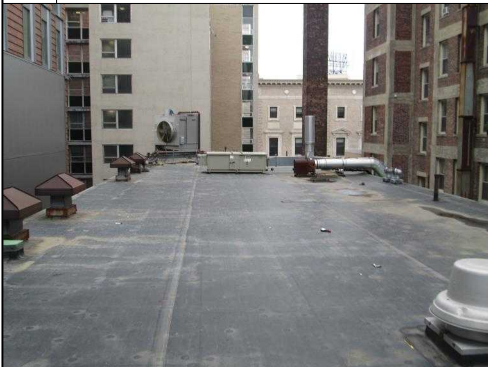
12. Side EPDM roof
