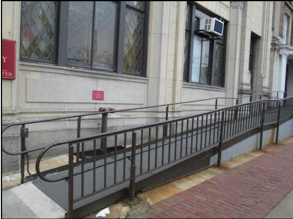
7. Exterior ADA ramp
