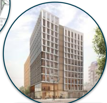
Portland 的多用途 12 层大型木结构建筑
