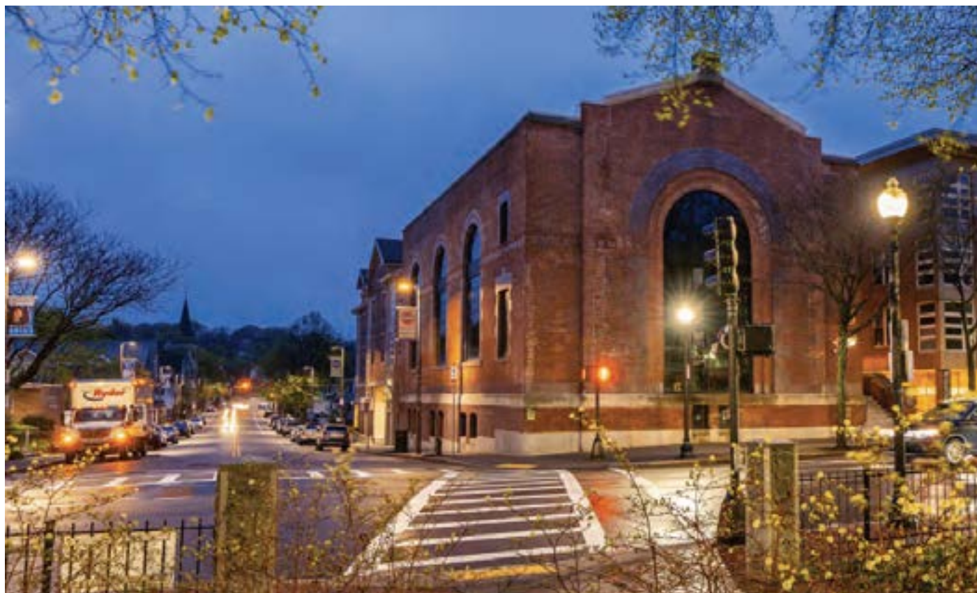
Figura 19. La subestación en Roslindale Square
