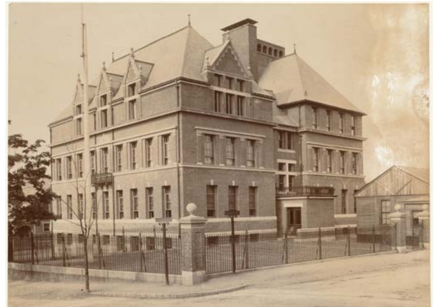
Figura 11. Imagen de Longfellow School, 1890. Biblioteca Pública de Boston, Archivo Fotográfico de Boston.
